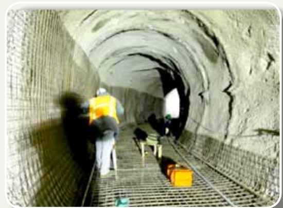
Instalación de niveles para hormigonado de solera
