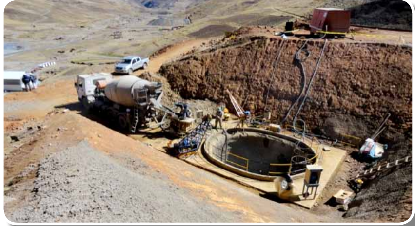
POZO DE COMPUERTAS BOCATOMA
