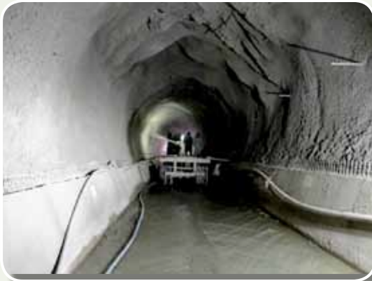
Hormigón proyectado progresiva 0+110
