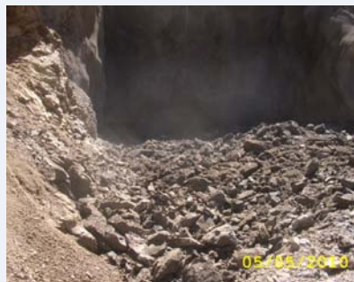
Material luego de Voladura
