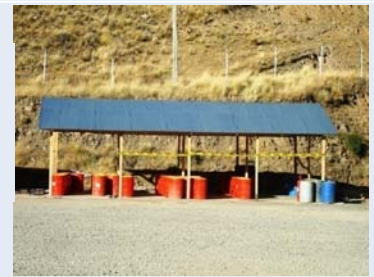
ALMACENAMIENTO DE CONBUSTIBLES Y LUBRICANTES
