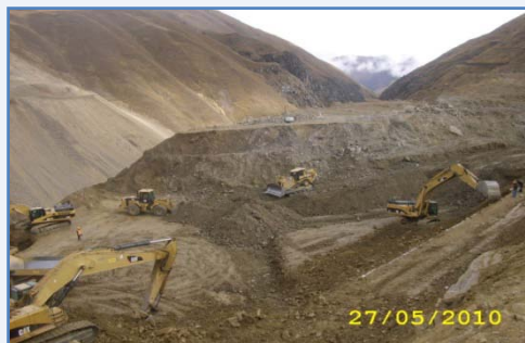
Excavación en sector de eje de plinto
