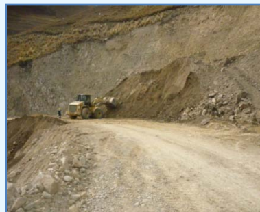
Remoción de derrumbes
