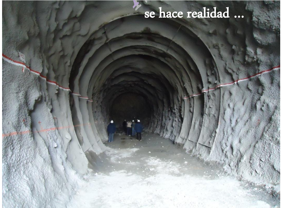
TÚNEL DE DESVÍO
