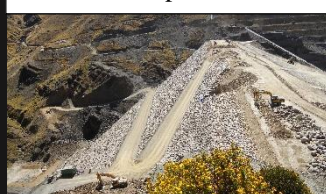
Altura de la presa 100 m.
