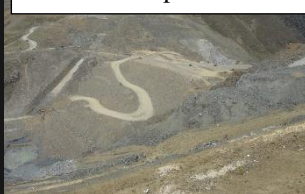
Altura de la presa 40 m.
