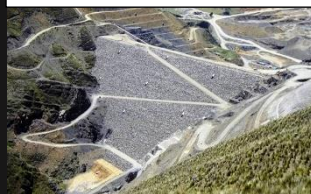
Altura de la presa 120 m.
