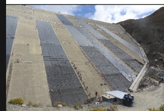
Vaciado de las losas
