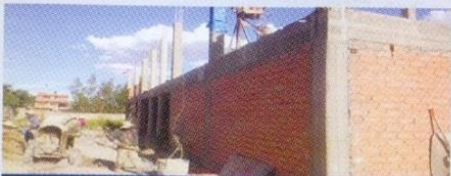
Construcción de la Casa de Control y Monitoreo ubicada en el municipio de Tiquipaya.
