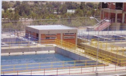
Planta de Tratamiento para potabilizar 1000 l/s de agua
