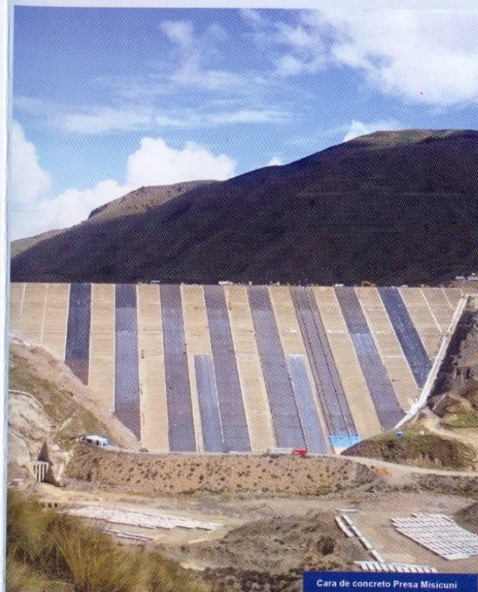
Cara de concreto Presa Misicuni
