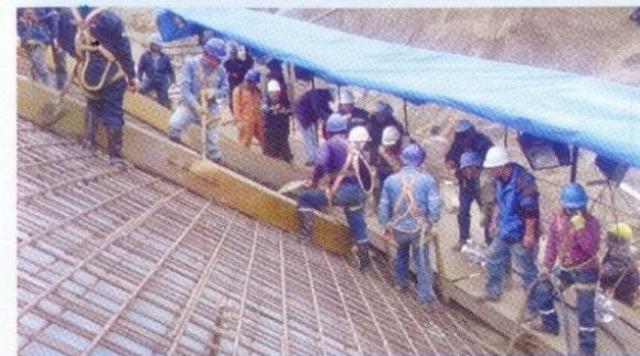
Hormigonado de la cara de concreto
