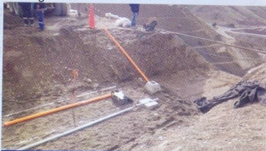
Instalación de medidor de asentamiento
