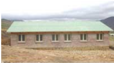
Posta Sanitaria Misicuni Ubicación: poblado Misicuni Sup. construida: 103 m 2
