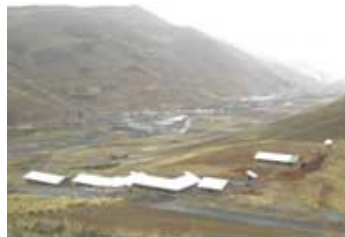
Nuevo poblado Patapampa – San Isidro
