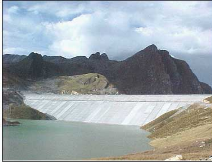
Presa de similares características
