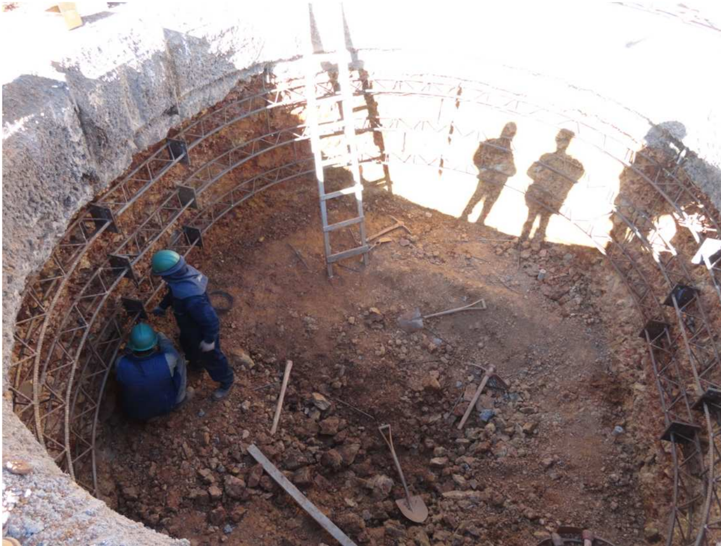
Pozo de Compuertas BOCATOMA
