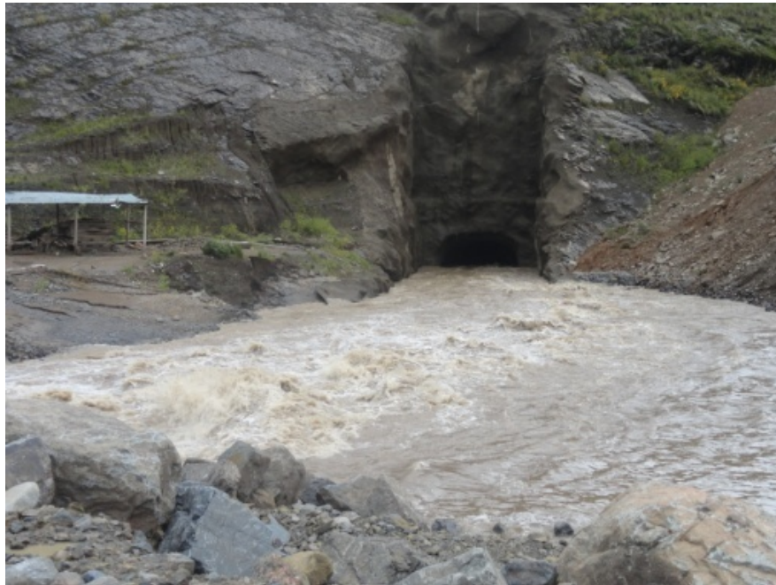
Avenida transitando por el túnel de desvío
