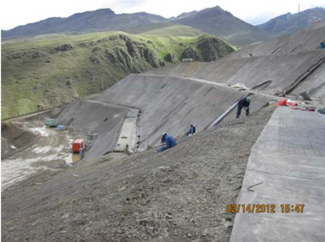
Colocado de malla electro soldada entre cotas 3800 a 3790
