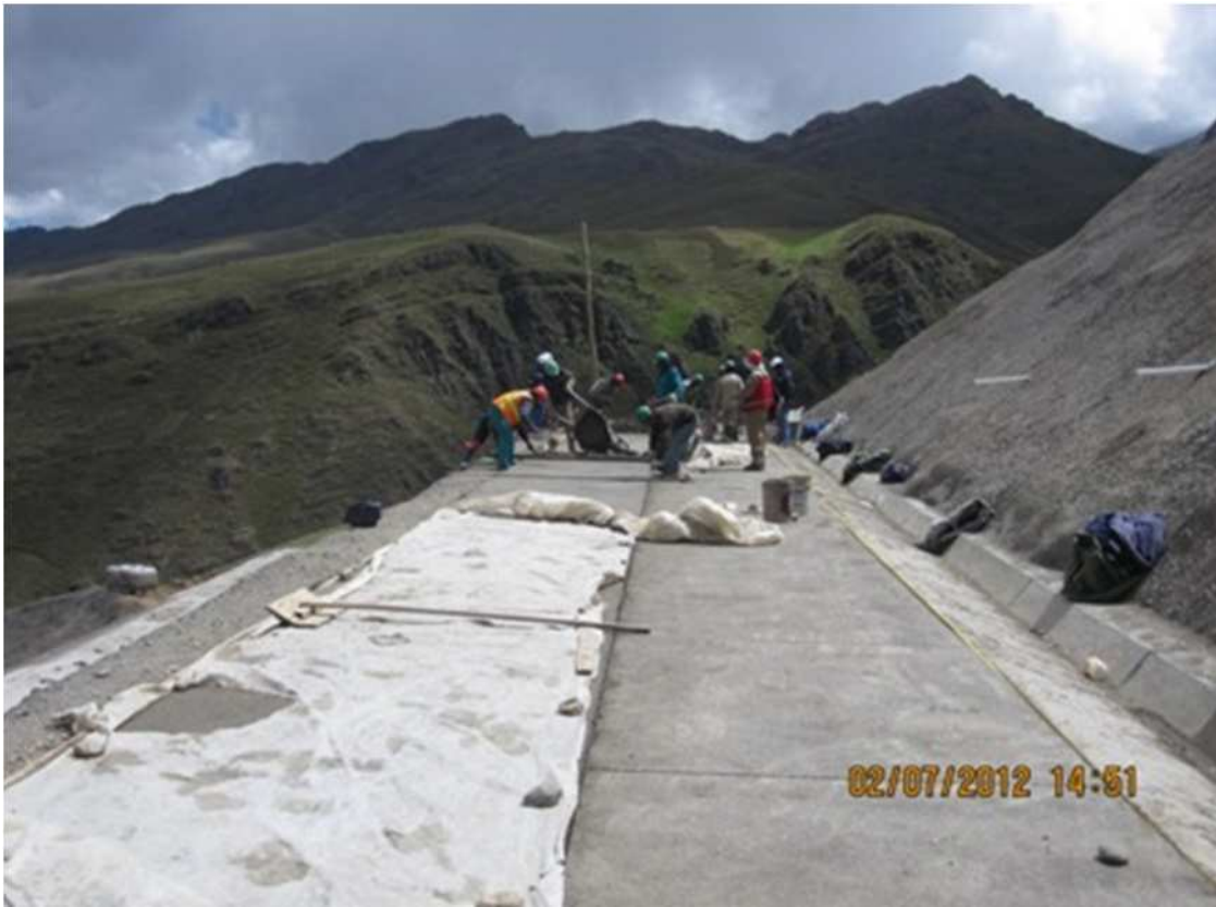
Vaciado de losa de mortero de cemento en banquina 3815
